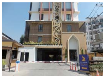
写真1 THE SIRI コンドミニアム外観
